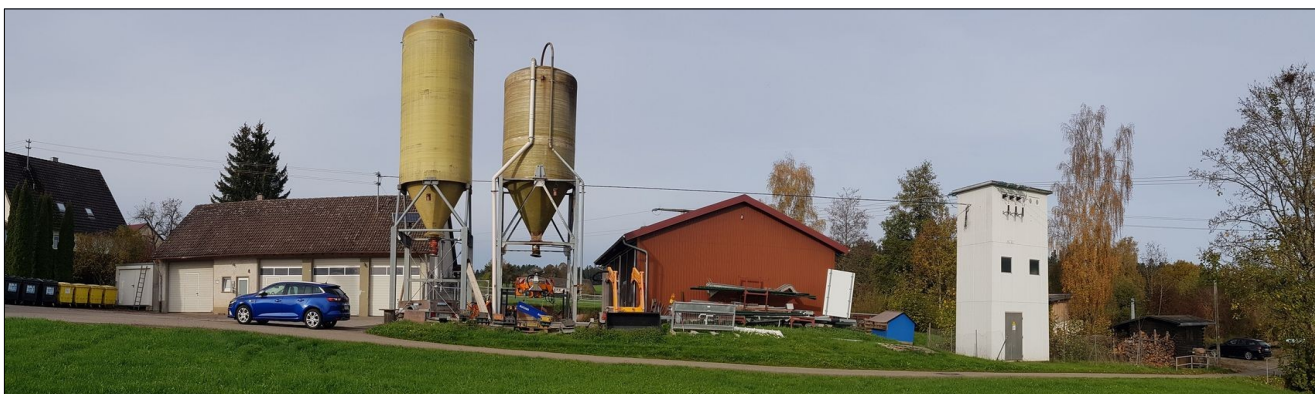
Ansicht aus Osten auf das bestehende Bauhofgelände.
